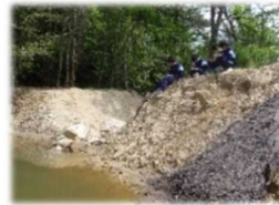
斜面が削られた Z 池
